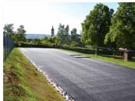
Wassererwärmung im Spessartbad
